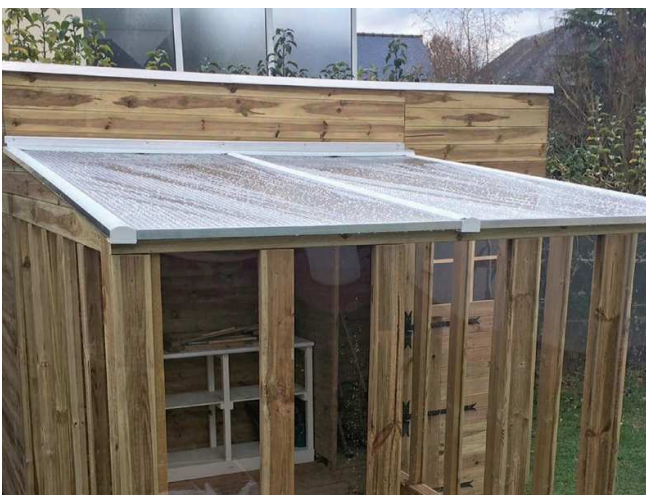
Couverture annexe en polycarbonate 10 mm
