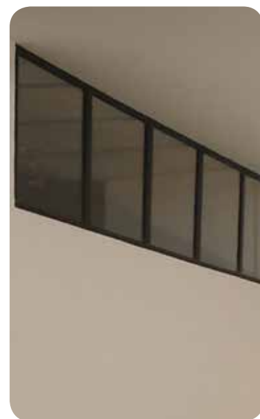
VITRAGE CAGE D'ESCALIER
