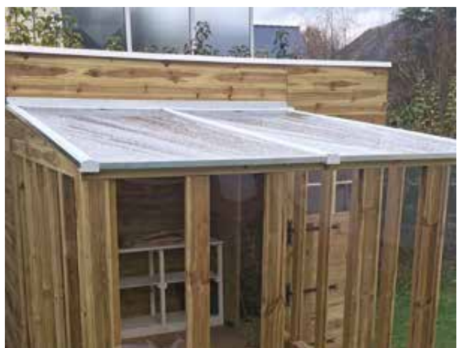
Couverture annexe en polycarbonate 10 mm
