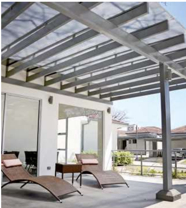
Couverture de terrasse en polycarbonate transparent
